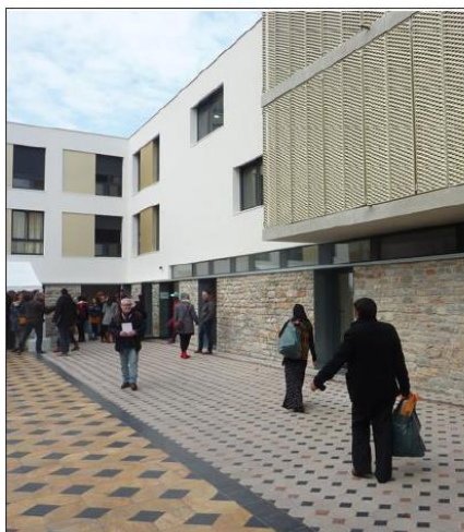
■ Le sol est celui (reconstitué) de la nef de l'ancienne église. À droite en haut, on devine les balcons – fermés ou non – des logements sociaux. Au fond, le bâtiment du CHRS. Photo Emmanuelle BABE
